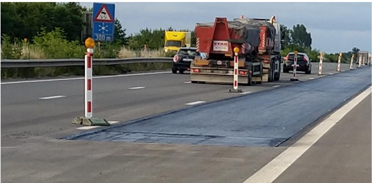
Figuur 8 Minder dan een halve meter tussen bakens en werf
