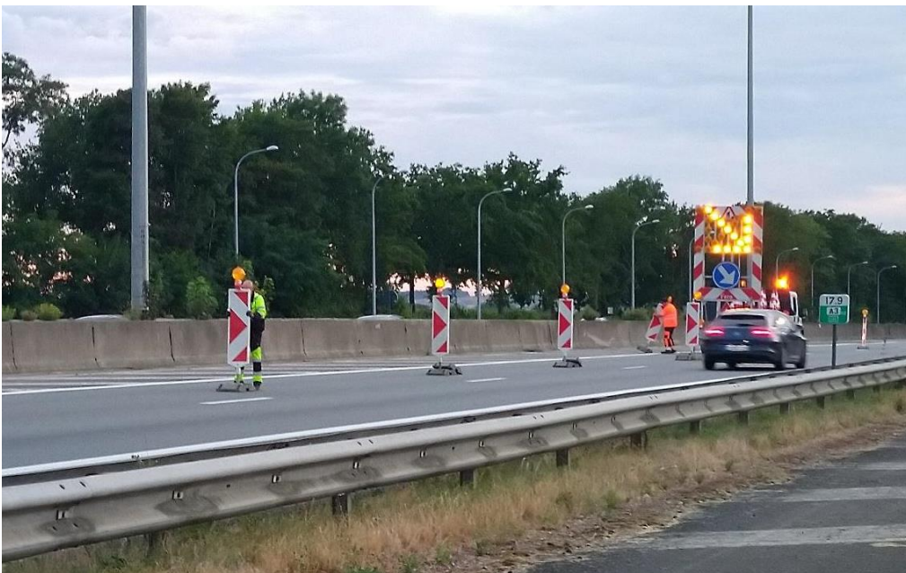
Figuur 12 Afsluiten rijstrook richting Brussel
