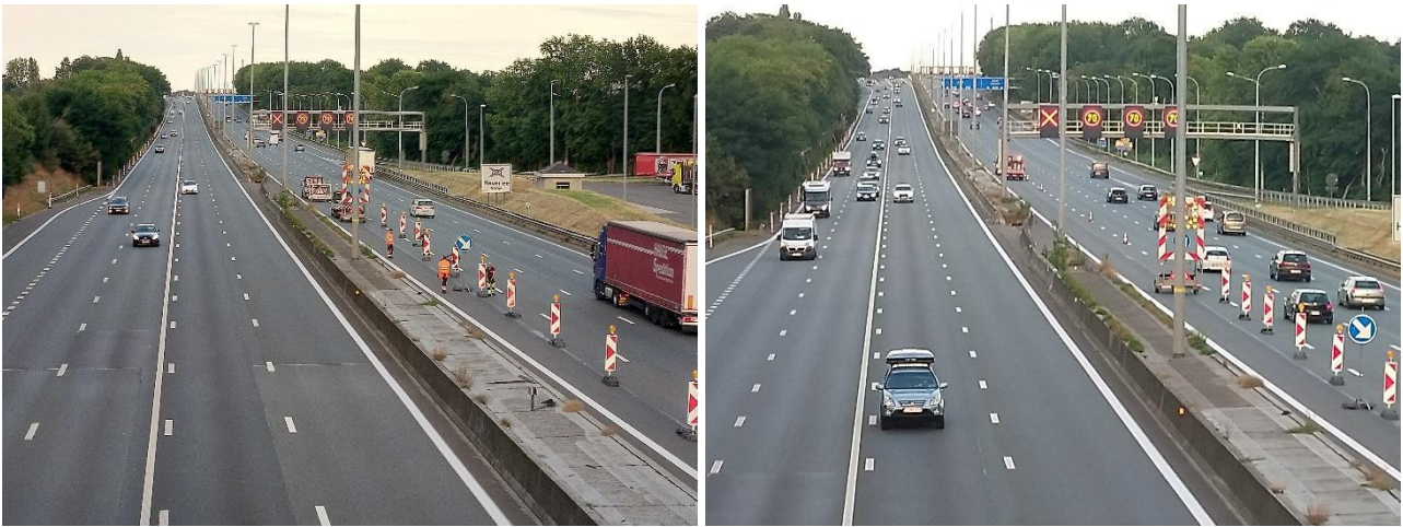
Figuur 11 Plaatsen van verkeerskegels voorafgaand aan de afschermende constructie
