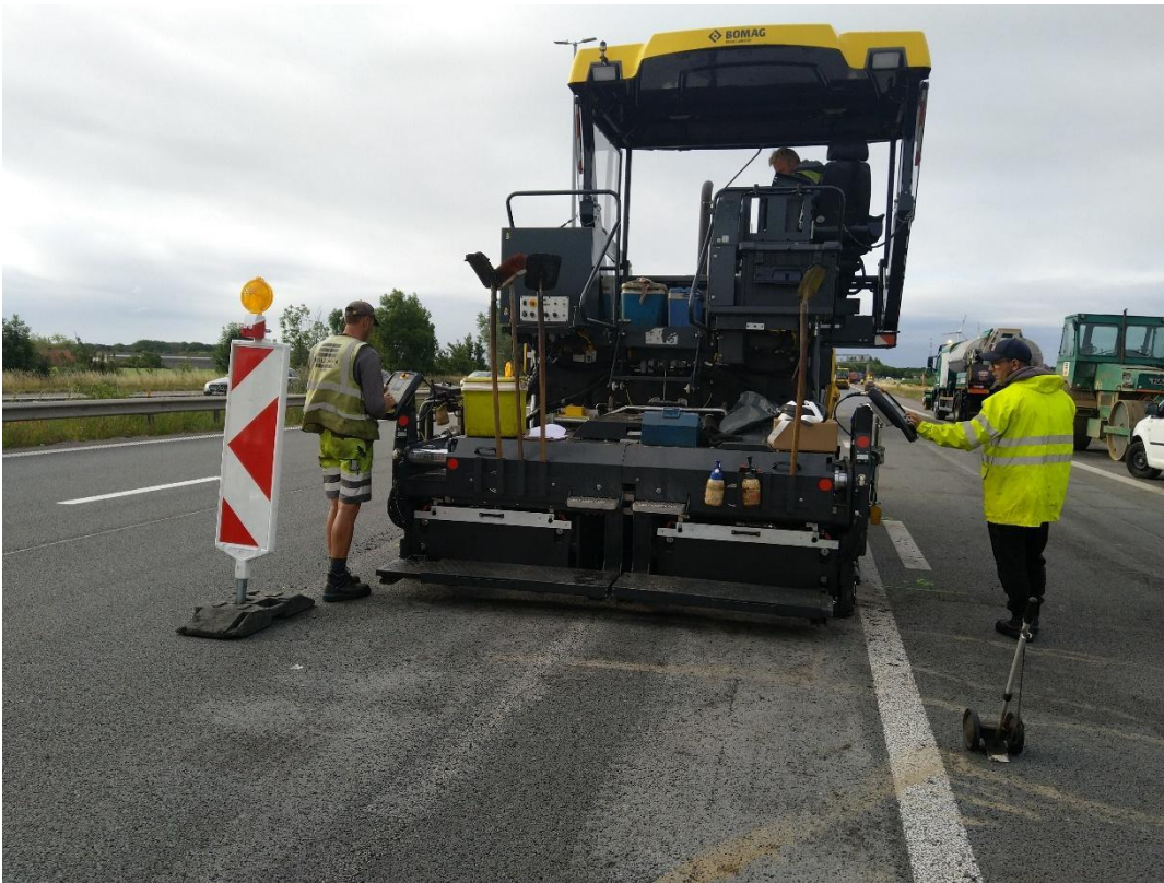
Figuur 7 Bedienen van de asfalteermachine
