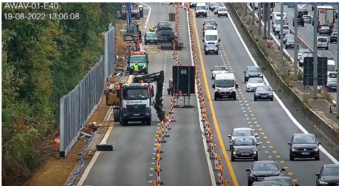
Figuur 25 E40 – graafmachine verschuift bakens
