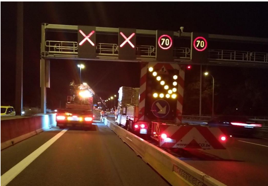
Figuur 14 Plaatsen afschermende constructie
