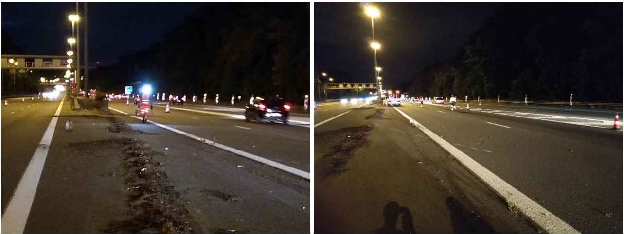
Figuur 13 Schoonmaken doorsteek en verplaatsen van de kegels
